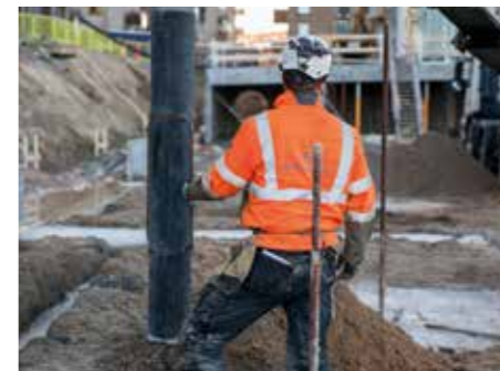
Betonarbejde i Åbyen.
