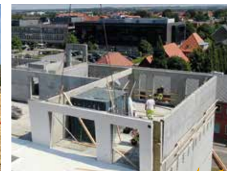
Elementer monteres i Herning på Møllehøj.
