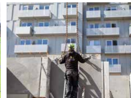
Elementmontage i Åbyen på byggefelt B.
