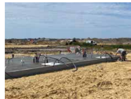
Et fundament ud af 280 bliver færdiggjort i Søndervig.
