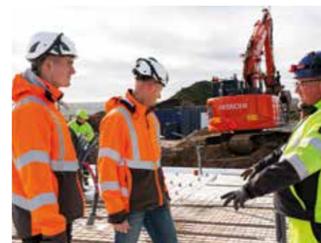
Fundamenter støbes på Lisbjerg, Aarhus.
