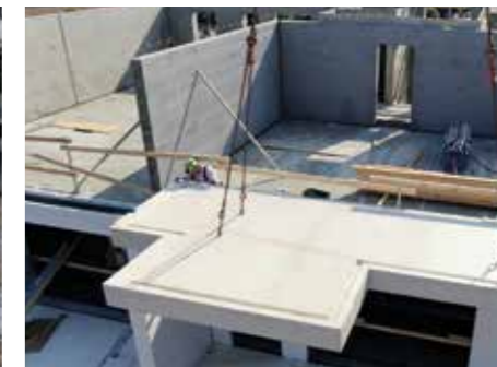
Terrasser monteres på Møllehøj i Herning.
